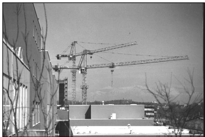
Foto 1 : cantiere nel quale sono presenti due gru
