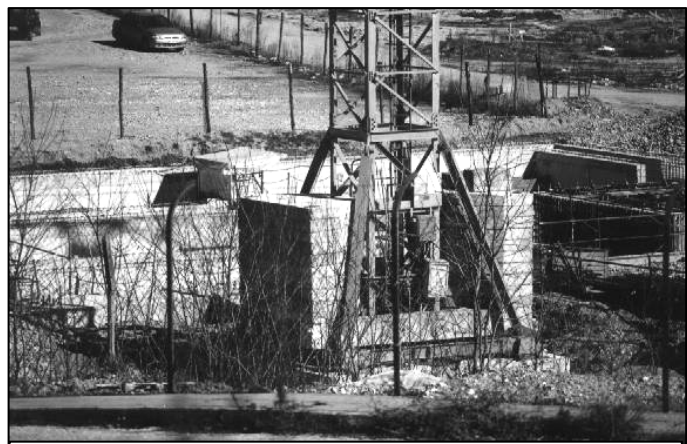
Foto 2: Zavorra di stabilizzazione
