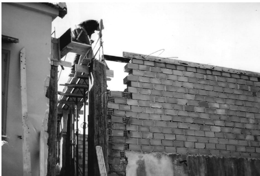
Foto 1- Lavoratore durante la realizzazione delle travi perimetrali. Non è stato allestito alcun ponteggio né opere provvisorie.
