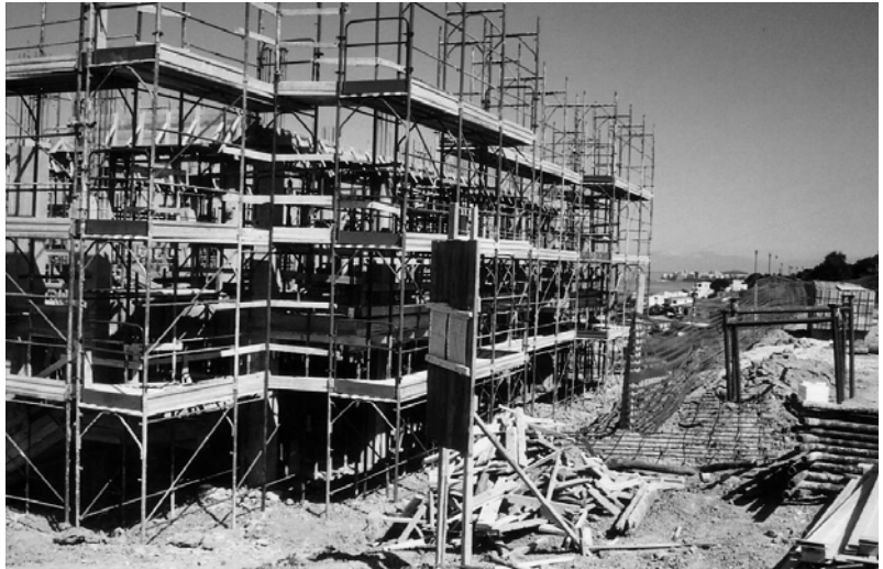
Foto 1: Idonea installazione di ponteggio metallico con ponte e sottoponte di sicurezza
