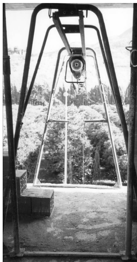
Foto 4: Argano a cavalletto privo di tavola fermapiede con altezza non inferiore a 30 cm.
