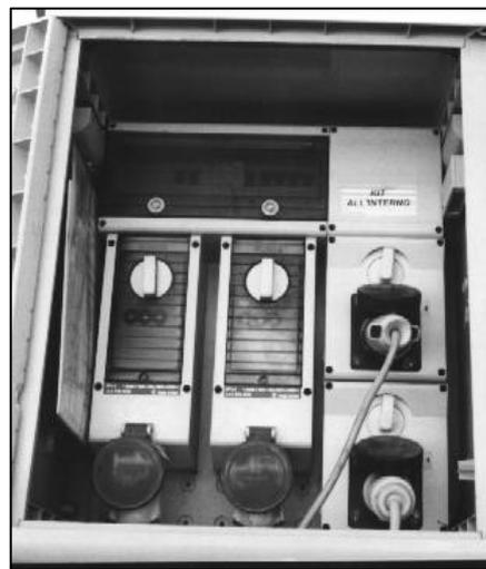
Foto 5: Idoneo quadro elettrico da cantiere da utilizzare per l'alimentazione della molazza e della betoniera
