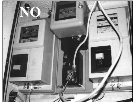
Foto 6: Energia elettrica da cantiere prelevata direttamente dal Distributore.
