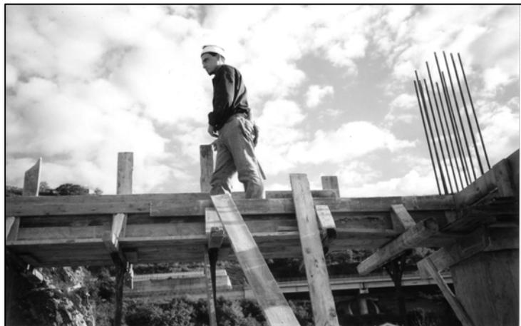
Foto 1 : Struttura in c.a. priva di protezione perimetrale
