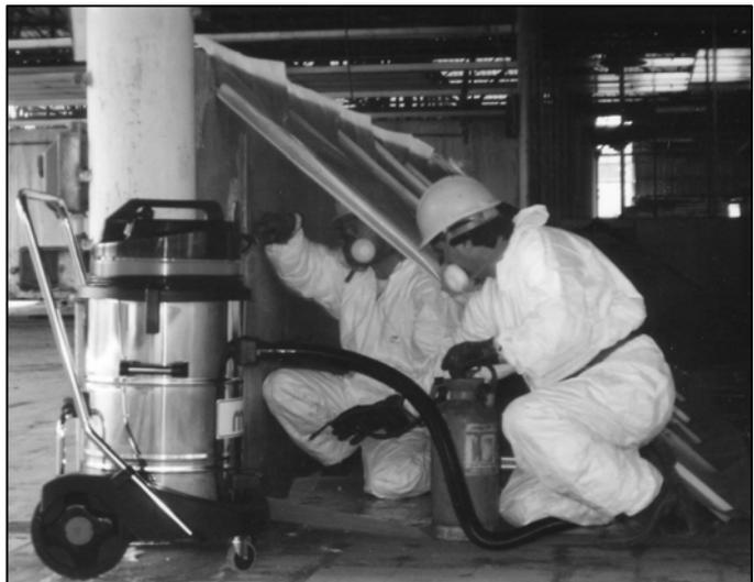
Foto 6: Personale qualificato durante la rimozione di materiale contenente amianto
