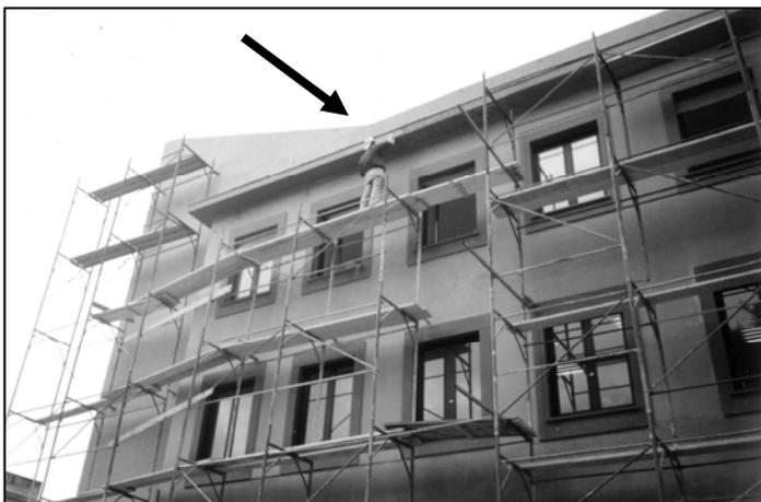
Foto 5 : Lavoratore sul ponteggio metallico privo di ogni elementare misura di sicurezza
