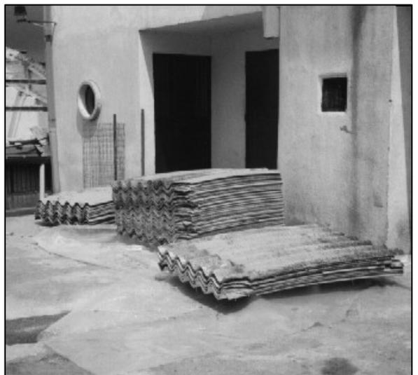
Foto 2: Lastre ondulate in cemento-amianto, su teli di polietilene per l'imballaggio.
