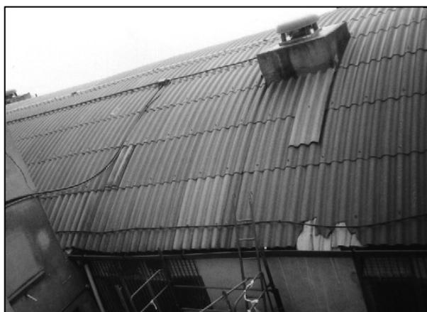
Foto 1 – Capannone con copertura in pannelli ondulati in cemento – amianto, in cattivo stato di conservazione
