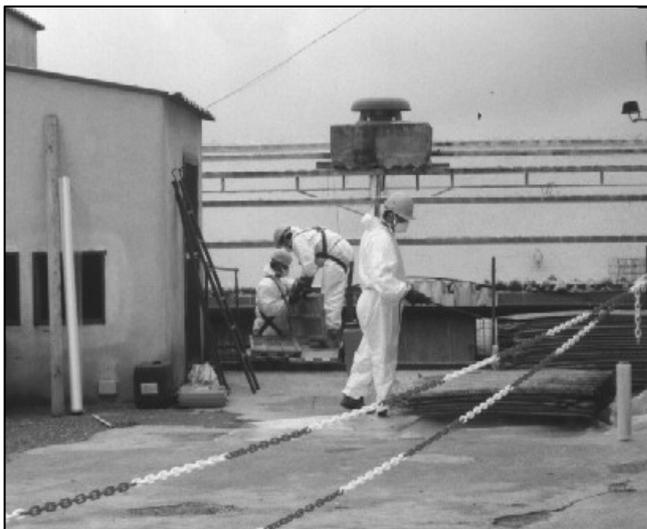
Foto 6: Lavoratori qualificati, durante le fasi di rimozione delle lastre ondulate in cemento-amianto
