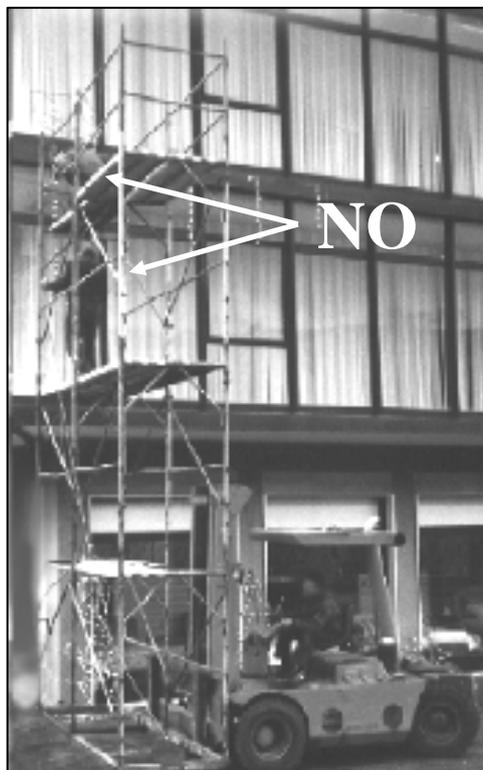
Foto 1: uso improprio del carrello elevatore (muletto)
