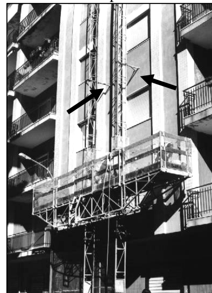
Foto 1 – Ponteggio autosollevante: ancoraggio con piastra e contropiastra
