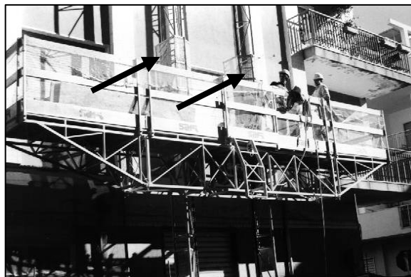
Foto 2 – Piattaforma: griglie di protezione alle strutture verticali
