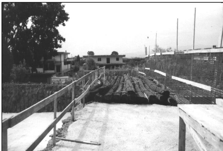
Foto 2: deposito di tonnellate di barre di ferro sul ciglio dello scavo
