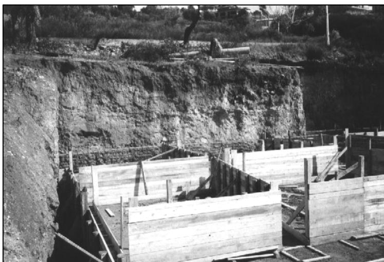
Foto 1: Pareti dello scavo, in terreno argilloso, prive di armature; pericolo gravissimo per i lavoratori addetti.
