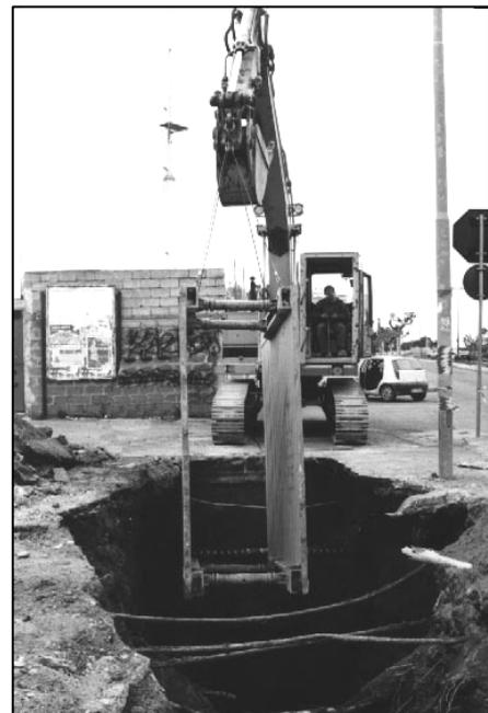
Foto 4: posizionamento dell'armatura nello scavo
