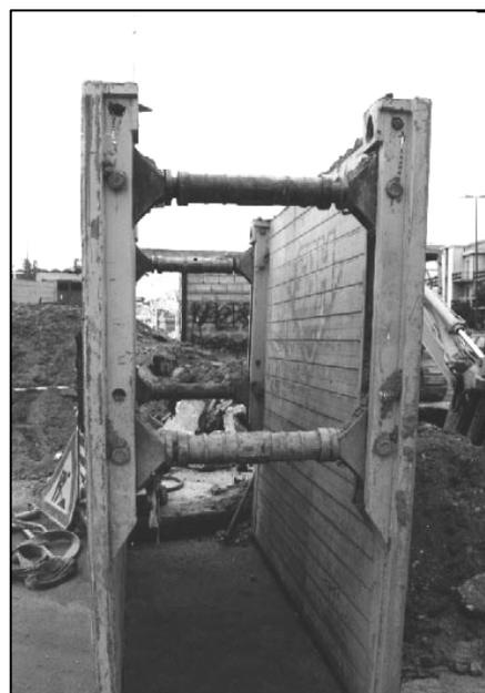
Foto 3: Tipo di armatura per le pareti dello scavo
